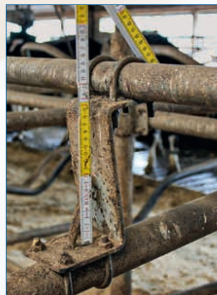
Falsch eingestellte Nackenrohre sind häufig ein Problem. Das Nackenrohr lässt sich z. B. mit einem gewinkelten Flacheisen hochsetzen. Foto: Glatz-Hoppe
